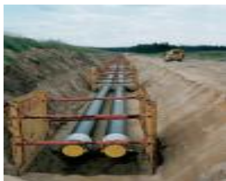
Figura 50 a-gypat e vendosur në trase, b-shiriti lajmërues mbi aksin e gypave
